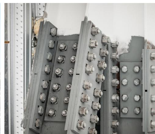
F 预钻孔板和结构螺栓
